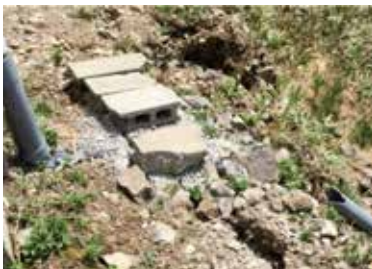
山小屋裏の亀裂
